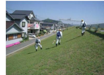
堤防点検状況
