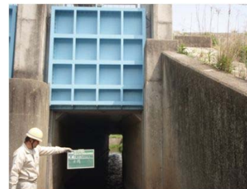
樋門等の点検状況
