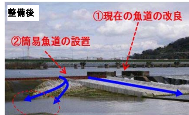
潮止堰魚道の改良
