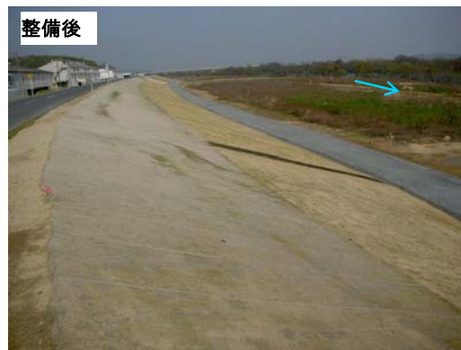
堤防補強（浸透対策）の実施状況（船穂地先）
