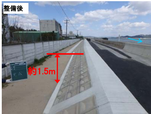
築堤（高潮堤） 暫定堤防の実施状況（乙島地先）
