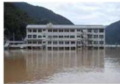
H26. 8 避難所2階の浸水(徳島県)
