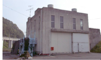
軽部排水機場(ポンプ場)
