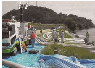
排水ポンプ車操作訓練(高梁川)
