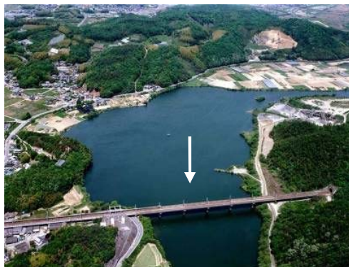
高梁川派川 柳井原貯水池
