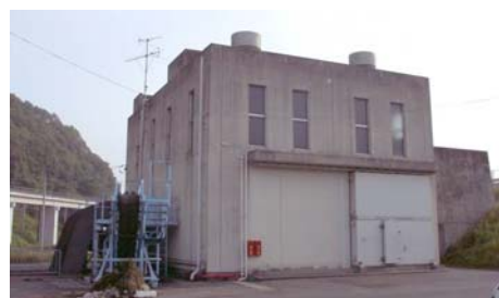
軽部排水機場(ポンプ場)
