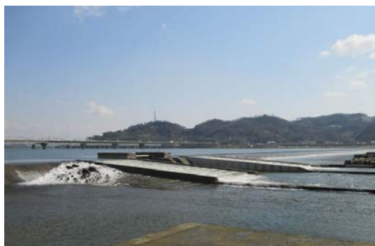
魚道現況（潮止堰：改良後）
