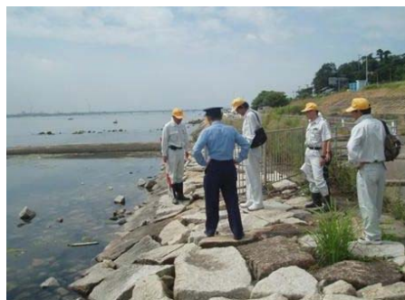
共同安全利用点検の状況（高梁川）
