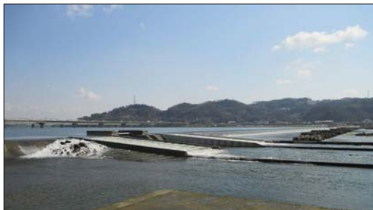
潮止堰の魚道の現状
