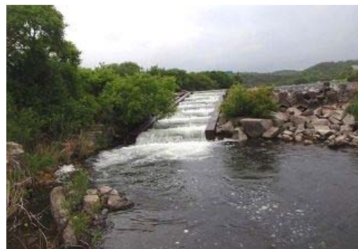
魚道現況（笠井堰）
