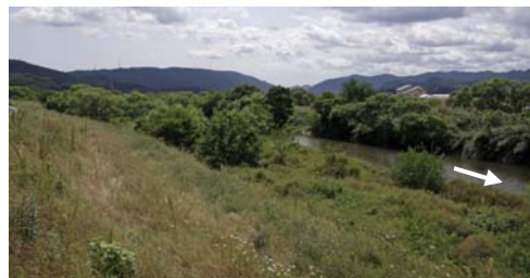
小田川 植生の繁茂状況
