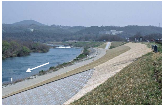
堤防補強の状況（高梁川酒津地区）
