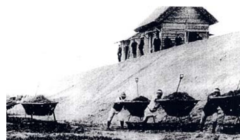
酒津付近の築堤工事（明治44年）
