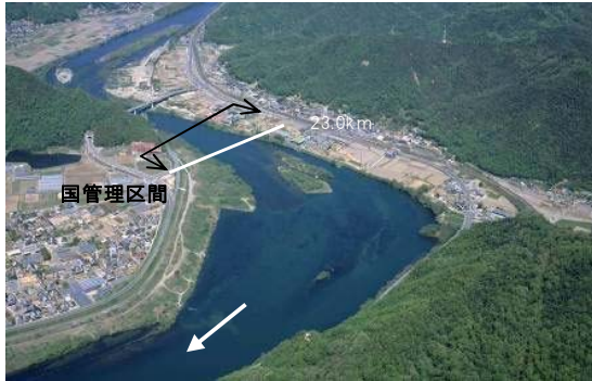
高梁川 国管理区間の上流端付近
