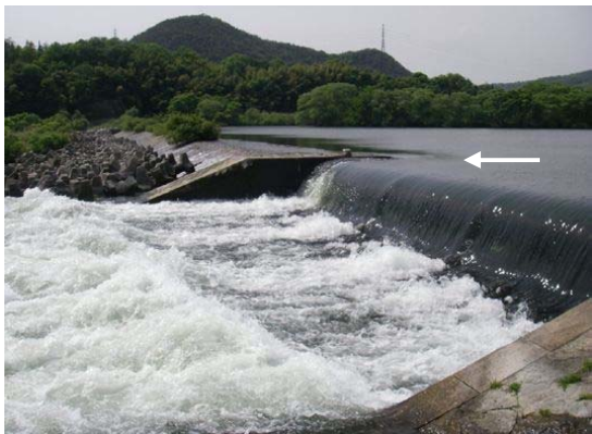
笠井堰 (固定堰)
