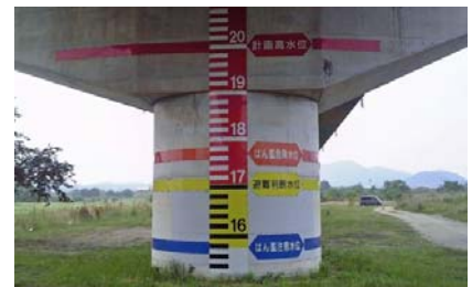
橋脚への量水標の設置状況 (高梁川)
