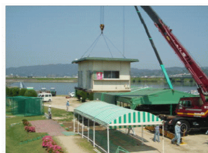
霞橋ゴルフ場上屋の撤去訓練
