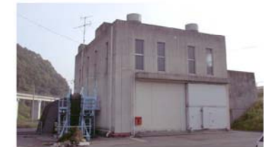
軽部排水機場(ポンプ場)
