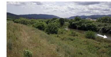
小田川 植生の繁茂状況
