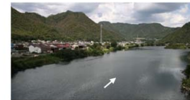
高梁川 国管理区間の上流端付近
