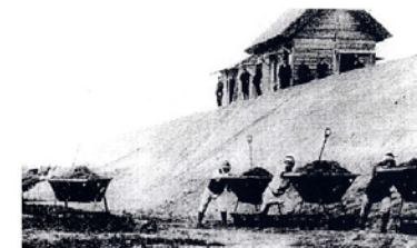
酒津付近の築堤工事（明治 44 年）
