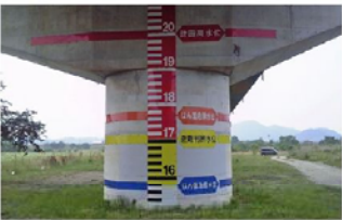
橋脚への量水標の設置状況 (高梁川)
