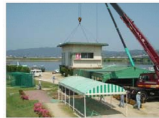
霞橋ゴルフ場上屋の撤去訓練
