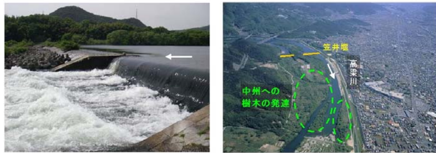
笠井堰(固定堰)
