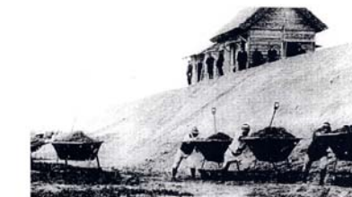
酒津付近の築堤工事（明治 44 年）
