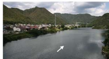
高梁川 国管理区間の上流端付近
