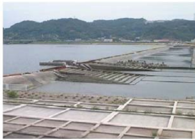
魚道現況(潮止堰)
