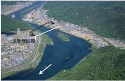
高梁川 国管理区間の上流端付近
