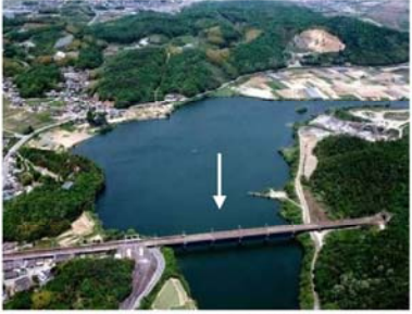
高梁川派川 柳井原貯水池
