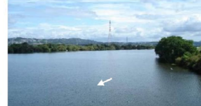
高梁川 潮止堰上流の湛水区間
