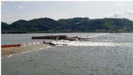
潮止堰の魚道の現状
