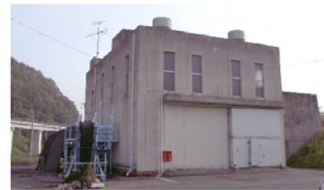
軽部排水機場(ポンプ場)
