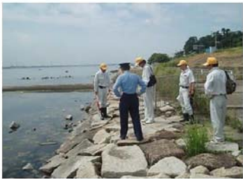
共同安全利用点検の状況（高梁川）
