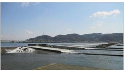
潮止堰の魚道の現状
