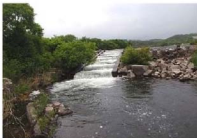
魚道現況(笠井堰)
