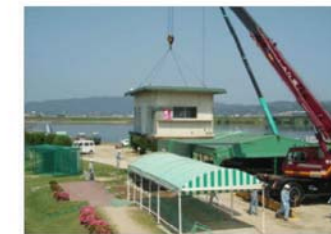
霞橋ゴルフ場上屋の撤去訓練
