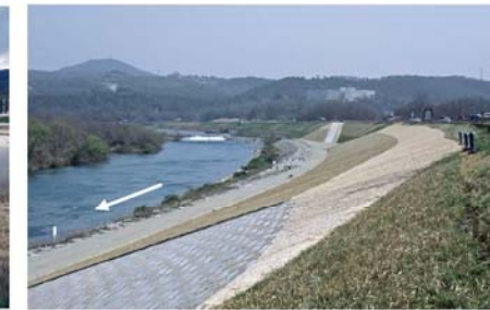
堤防補強の状況（高梁川酒津地区）
