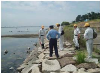
共同安全利用点検の状況（高梁川）
