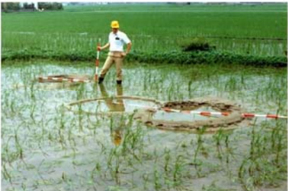
位置：倉敷市真備町 砂の噴出に伴う陥没の発生状況（昭和 60 年 6 月洪水）
