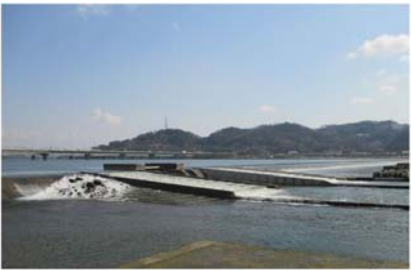
魚道現況(潮止堰：改良後)
