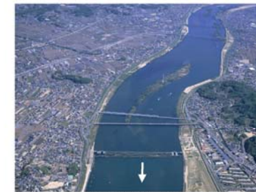
高梁川 潮止堰上流
