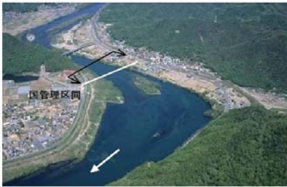
高梁川 国管理区間の上流端付近
