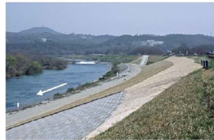
堤防補強の状況（高梁川酒津地区）
