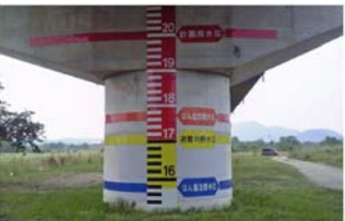
橋脚への量水標の設置状況 (高梁川)
