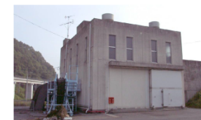
軽部排水機場(ポンプ場)
