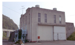
軽部排水機場(ポンプ場)
