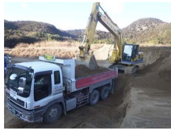
土砂採取 (仮置き場)
