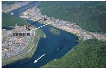
高梁川 国管理区間の上流端付近
