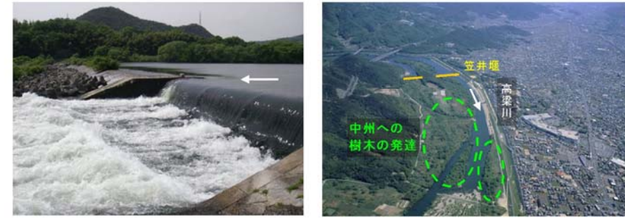
笠井堰(固定堰)
