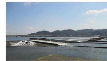
潮止堰の魚道の現状
