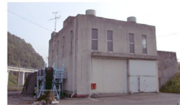
軽部排水機場(ポンプ場)
