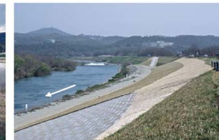
堤防補強の状況（高梁川酒津地区）
