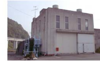
軽部排水機場(ポンプ場)
