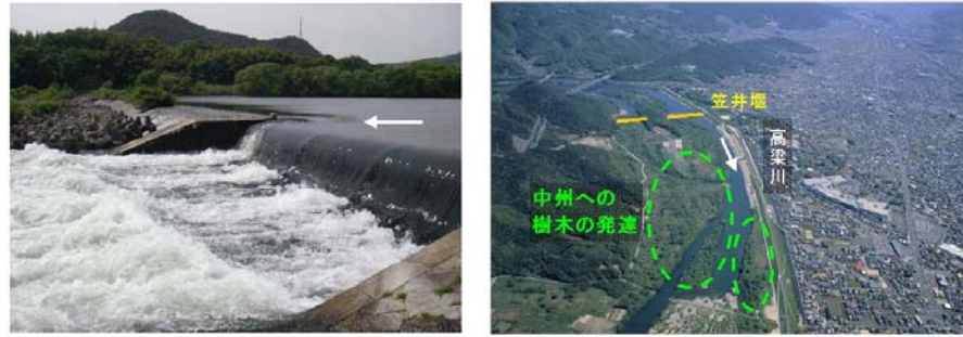
笠井堰(固定堰)
