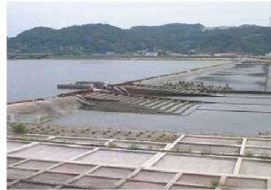
魚道現況(潮止堰)
