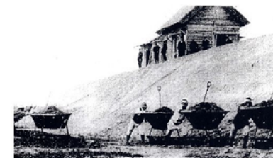
酒津付近の築堤工事（明治 44 年）
