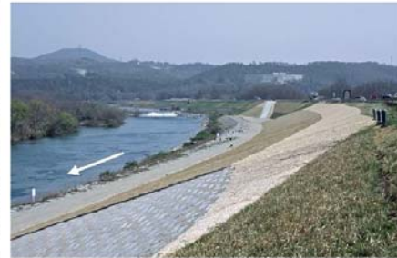
堤防補強の状況（高梁川酒津地区）
