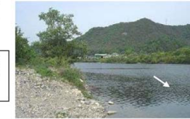
高梁川 高梁川合同堰（湛井堰） 上流の湛水区間 (国管理区間上流端の下流側)
