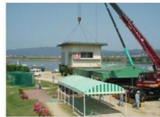
霞橋ゴルフ場上屋の撤去訓練
