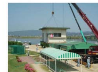
霞橋ゴルフ場上屋の撤去訓練
