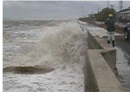
位置：倉敷市玉島乙島地区 高梁川の高潮越波状況（平成16年台風16号）
