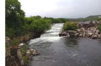
魚道現況(笠井堰)
