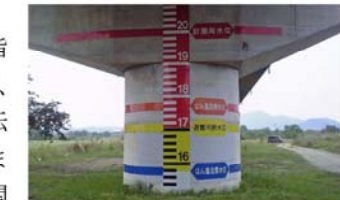
橋脚への量水標の設置状況 (高梁川)
