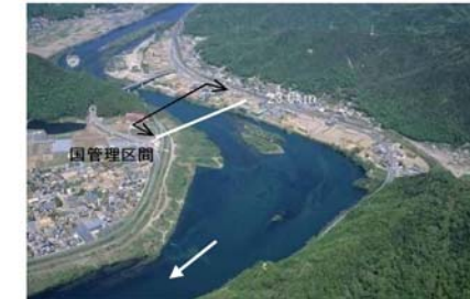
高梁川 国管理区間の上流端付近
