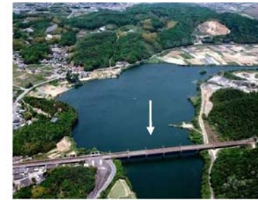
高梁川派川 柳井原貯水池
