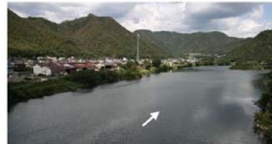
高梁川 国管理区間の上流端付近
