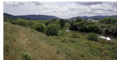
小田川 植生の繁茂状況
