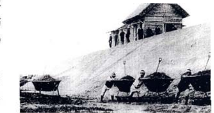
酒津付近の築堤工事（明治 44 年）
