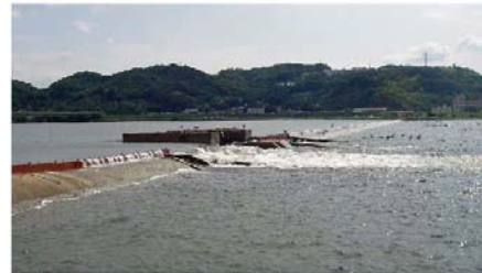
潮止堰の魚道の現状
