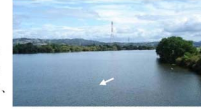
高梁川 潮止堰上流の湛水区間
