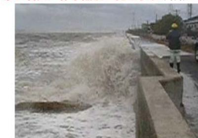
位置：倉敷市玉島乙島地区 高梁川の高潮越波状況（平成16年台風16号）
