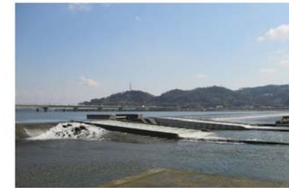
魚道現況(潮止堰：改良後)
