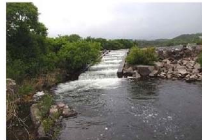
魚道現況(笠井堰)
