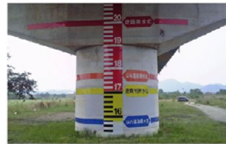
橋脚への量水標の設置状況 (高梁川)
