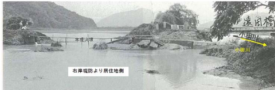
位置：倉敷市真備町遠田地区 出典：昭和 47 年豪雨災害誌（建設省） 小田川の堤防決壊による浸水状況（昭和 47 年 7 月洪水）
