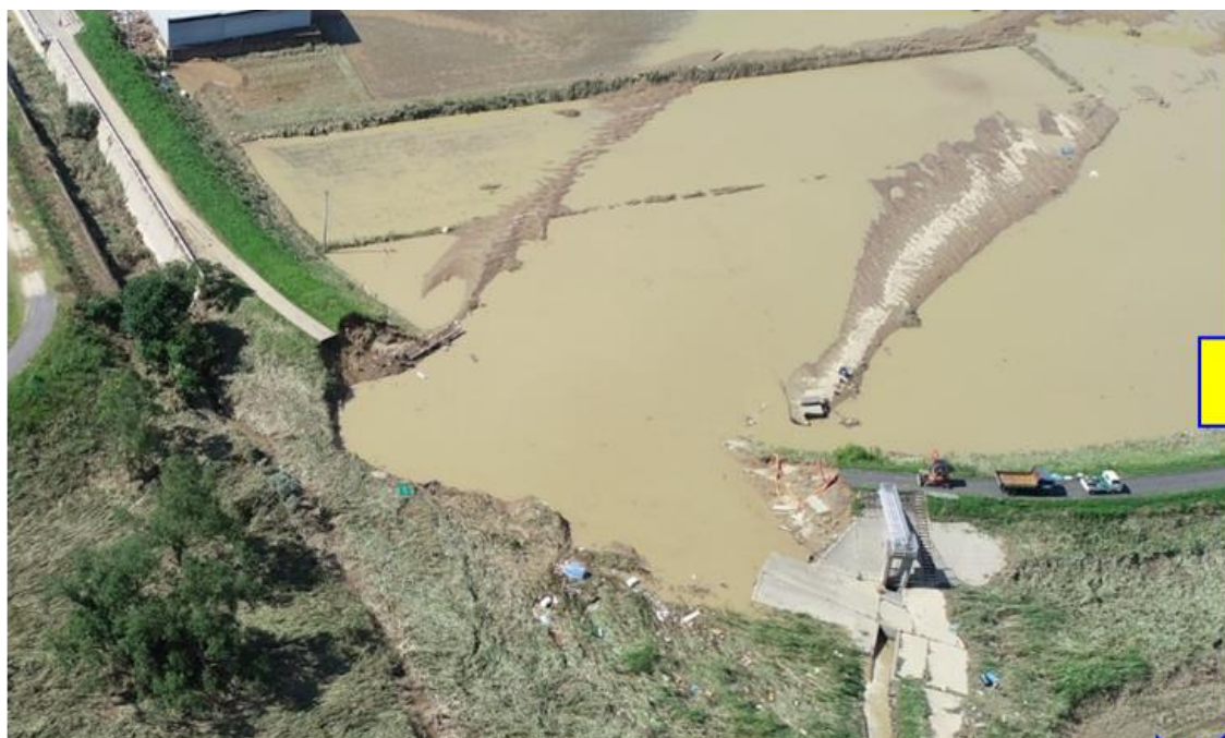
7月8日（日） 14:30に緊急対策工事に着手7月8日（日） 15:00頃撮影
