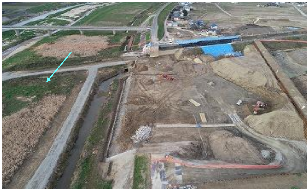
本復旧工事中(仮設堤防を撤去)
