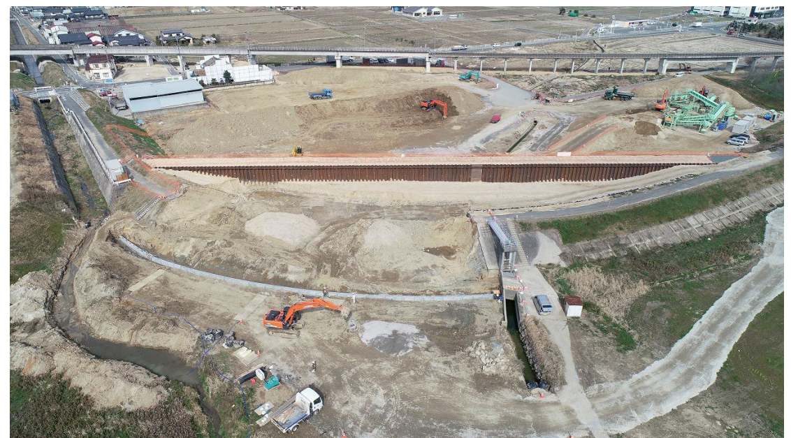
本復旧工事:堤防底部の地盤改良中(出水期までに完成予定)
