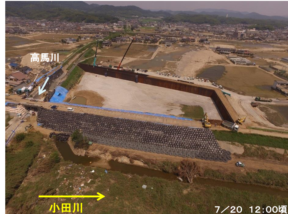
鋼矢板による二重締切堤防完了(緊急対策工事完成)
