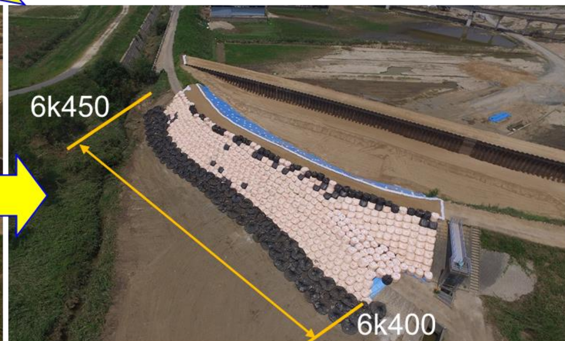
7月19日（木） 14:30 応急復旧対策完了 7月19日（木） 12:00頃撮影
