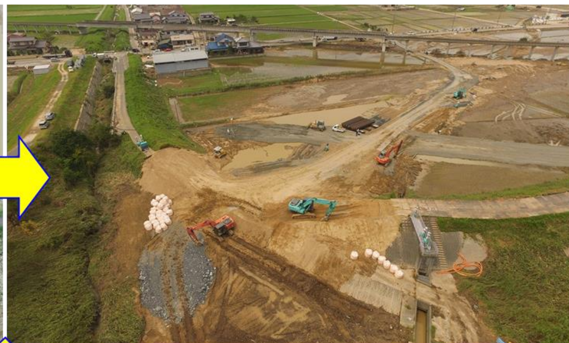
堤防締切盛土施工中 7月13日（金） 13:00頃撮影
