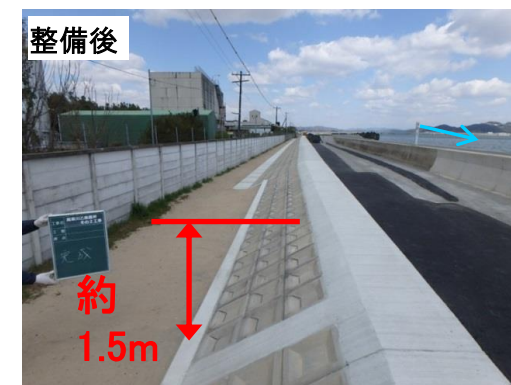
築堤（高潮堤）の実施状況（乙島地先）
