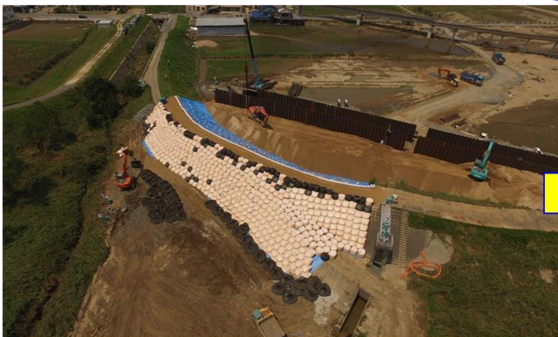
二重締切堤防（二重鋼矢板）施工中 7月16日（月） 13:00頃撮影
