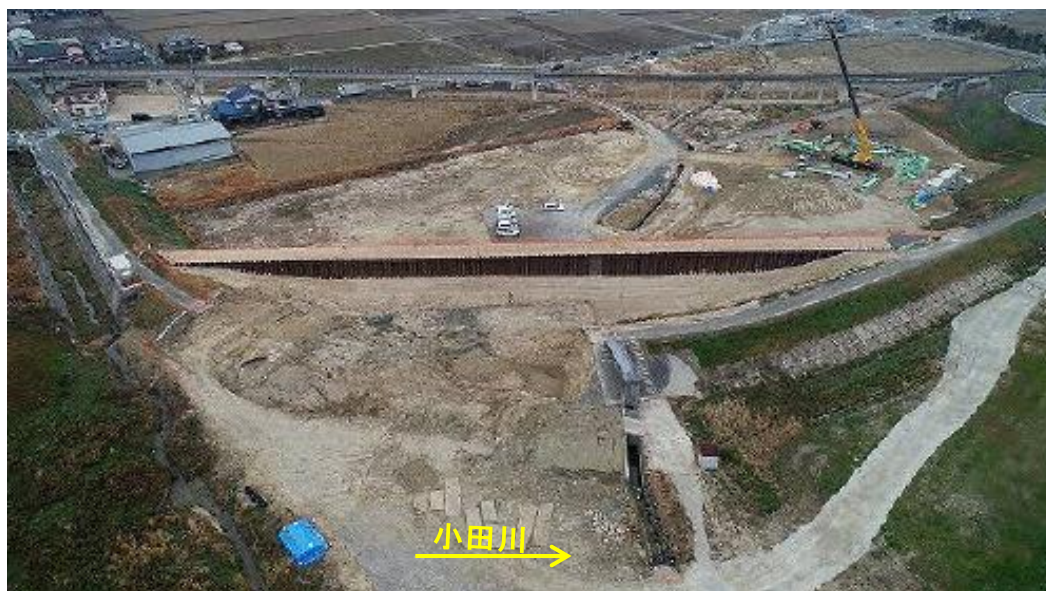
本復旧工事中(仮設堤防を撤去)
