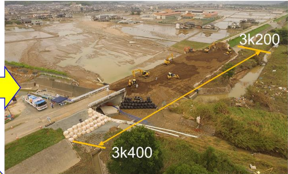
堤防締切盛土施工中 7月12日（木）14:00頃撮影
