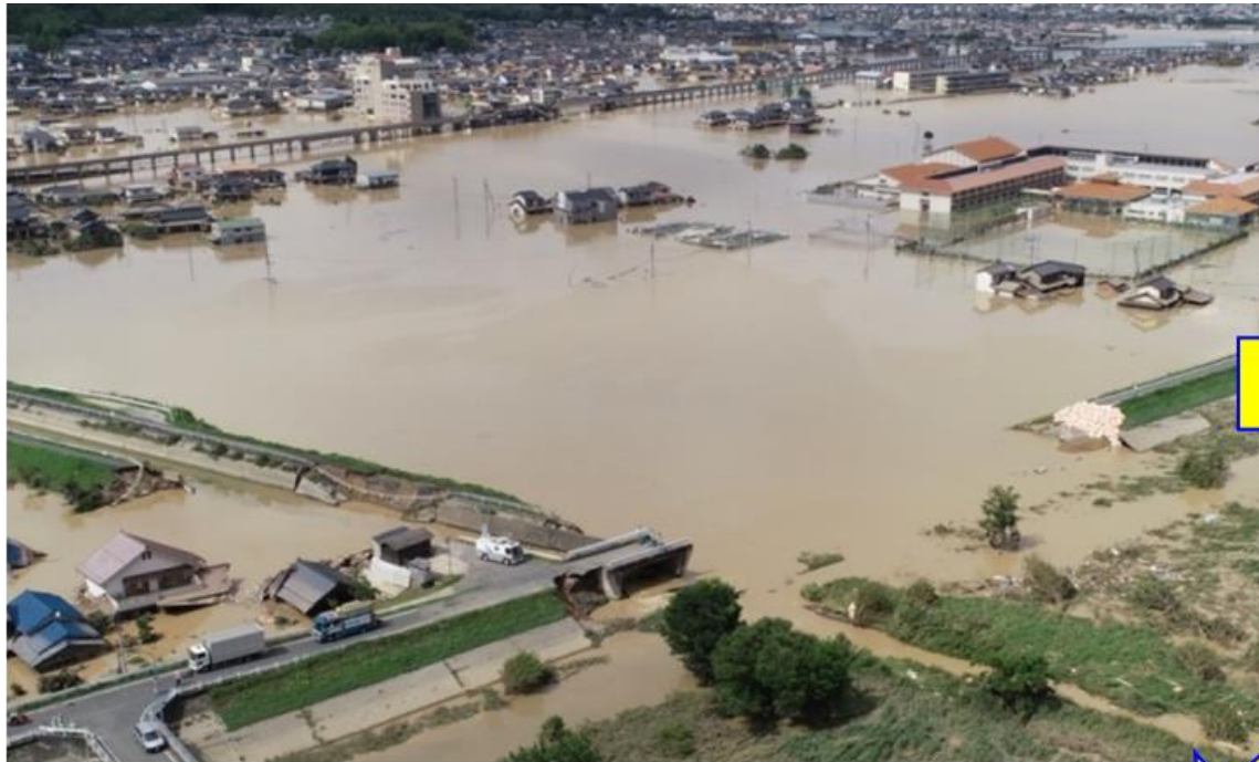
7月7日（土）22:00 緊急対策工事に着手 欠け口工完了済 7月8日（日）14:00頃撮影
