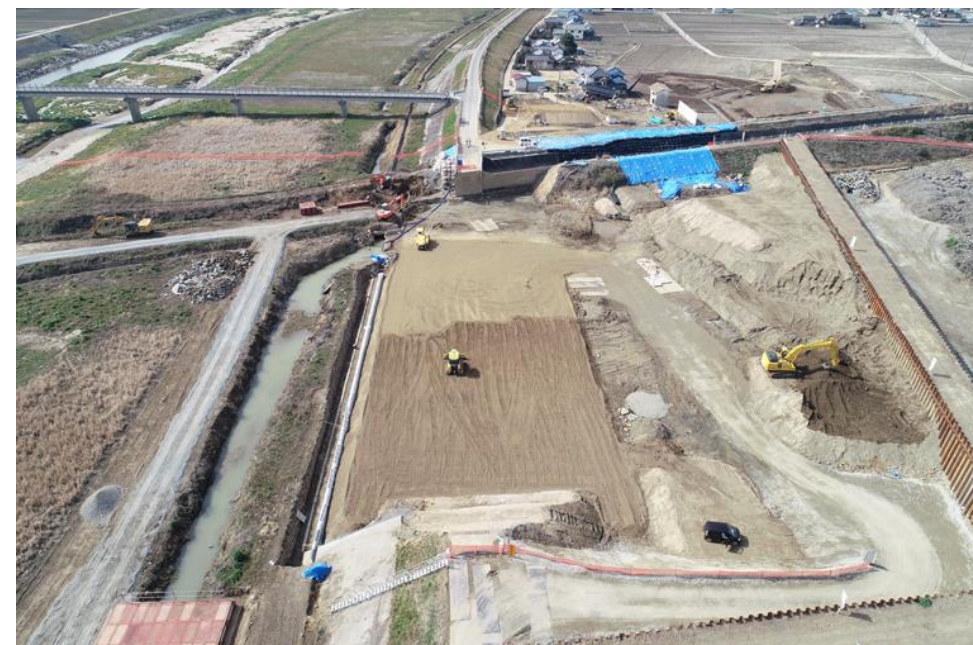
本復旧工事の盛土実施中(出水期までに完成予定)
