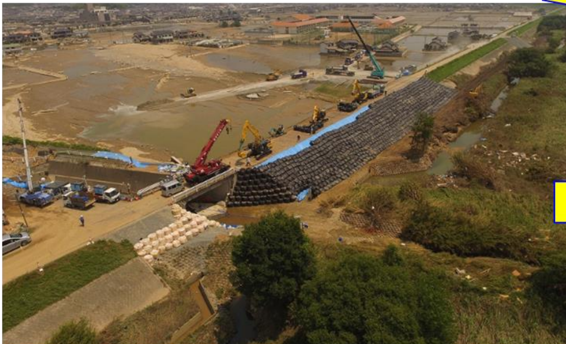
大型土のう施工中 7月15日（日）15:00頃撮影
