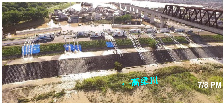
ポンプ車による排水作業状況
