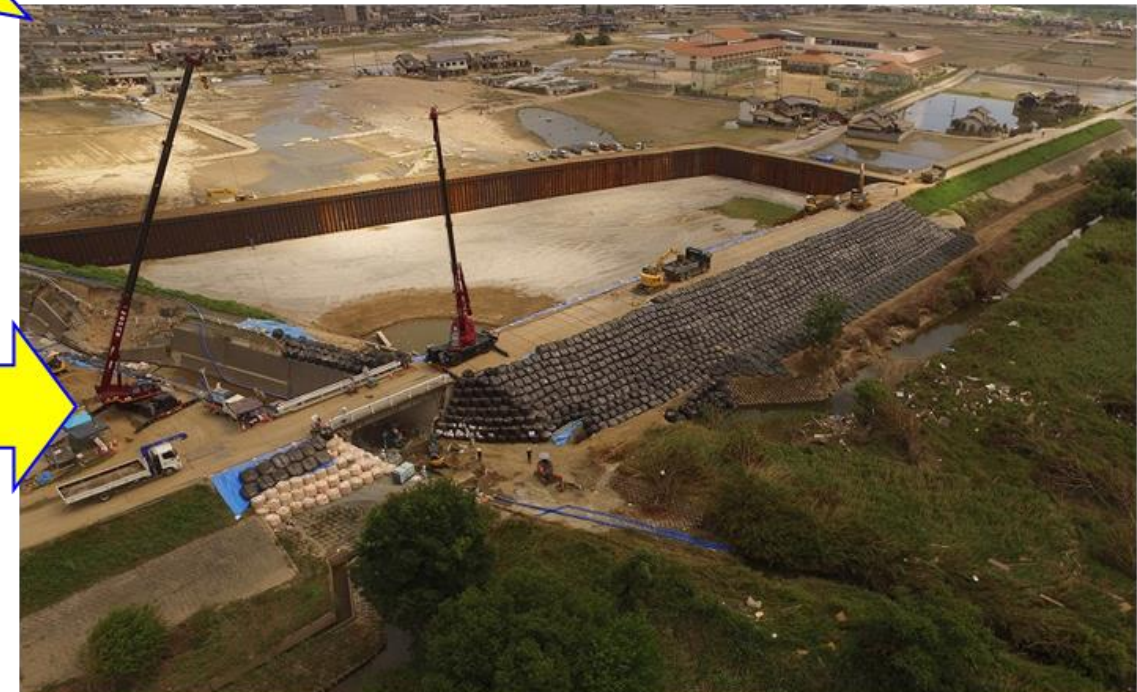
7月21日（土）10:00 応急復旧対策 完了 7月21日（土）11:00頃撮影
