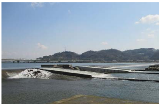
魚道現況（潮止堰：改良後）
