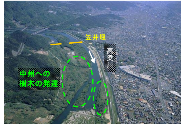
笠井堰付近の樹木の繁茂
