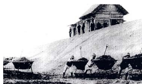
酒津付近の築堤工事(明治 44 年)
