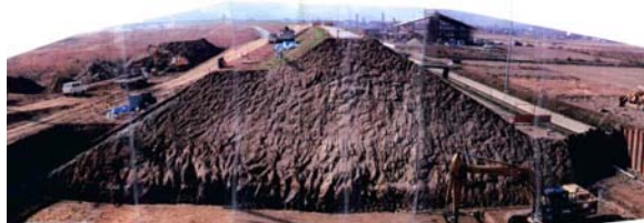
主に第一期改修に築造された小田川の堤防断面 (1 km 付近左岸)
