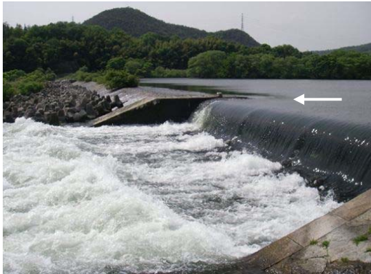
笠井堰(固定堰)
