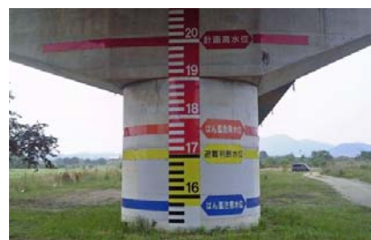
橋脚への量水標の設置状況 (高梁川)
