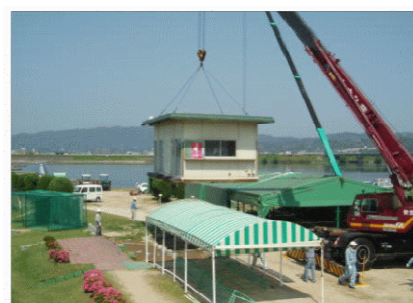
霞橋ゴルフ場上屋の撤去訓練
