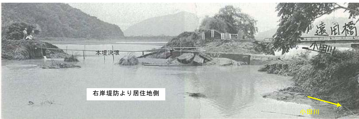
位置：倉敷市真備町遠田地区 出典：昭和47年豪雨災害誌（建設省） 小田川の堤防決壊による浸水状況（昭和47年7月洪水）
