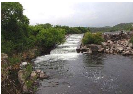
魚道現況（笠井堰）
