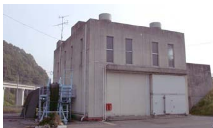
軽部排水機場(ポンプ場)
