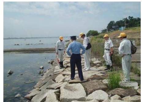
共同安全利用点検の状況（高梁川）
