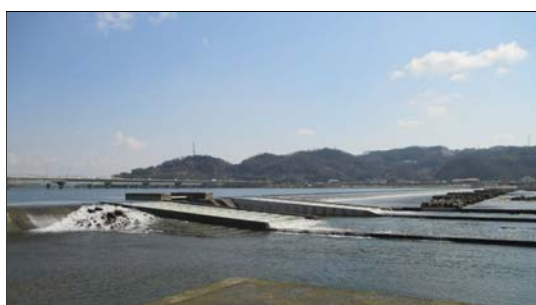
潮止堰の魚道の現状
