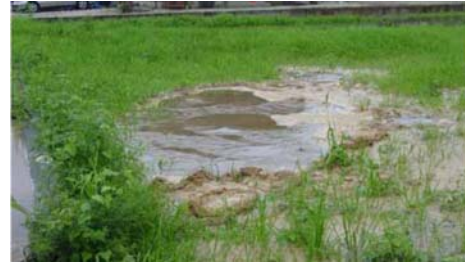
砂の噴出に伴う陥没の発生状況 (H18. 7 洪水、総社市清音地区) 洪水時に、堤防基盤からの漏水により、堤防から離れた所で水と土砂が吹き出したもの。
