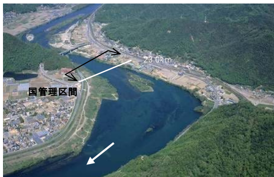
高梁川 国管理区間の上流端付近
