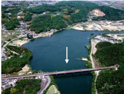
高梁川派川 柳井原貯水池
