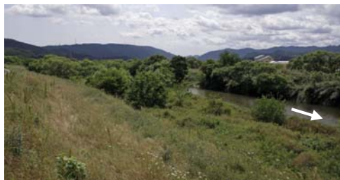
小田川 植生の繁茂状況
