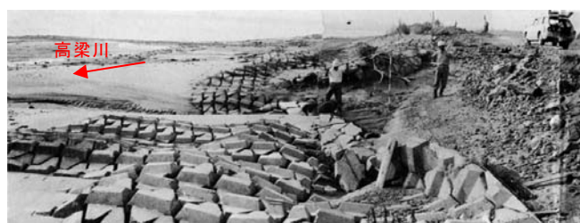
倉敷市鶴新田 低水護岸被災状況 出典：昭和 47 年 7 月豪雨災害誌（中国地方建設局） 高梁川の被災状況（昭和 47 年 7 月洪水）
