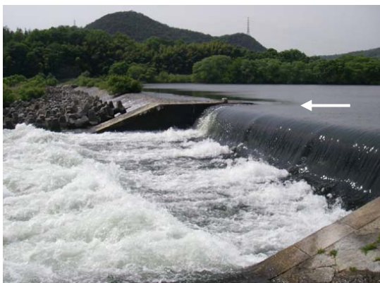
笠井堰(固定堰)
