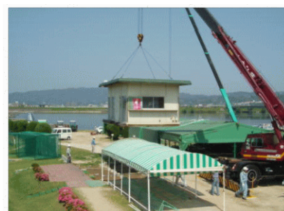
霞橋ゴルフ場上屋の撤去訓練
