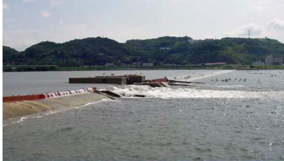
潮止堰の魚道の現状
