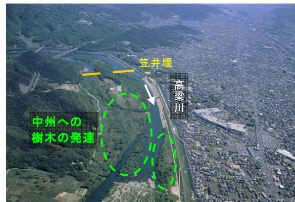
笠井堰付近の樹木の繁茂
