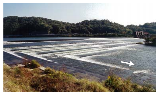
高梁川 高梁川合同堰(湛井堰)の階段式魚道
