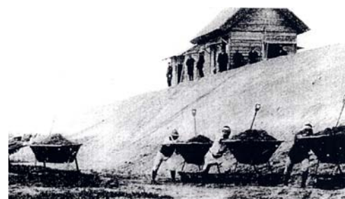
酒津付近の築堤工事(明治 44 年)
