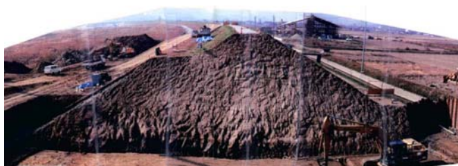
主に第一期改修に築造された小田川の堤防断面
