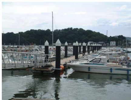
小型船舶係留施設(乙島西地区) (岡山県管理・収容165隻)
