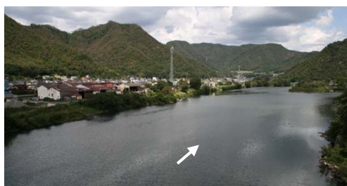
高梁川 国管理区間の上流端付近
