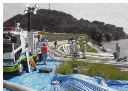
排水ポンプ車操作訓練(高梁川)
