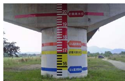
橋脚への量水標の設置状況 (高梁川)
