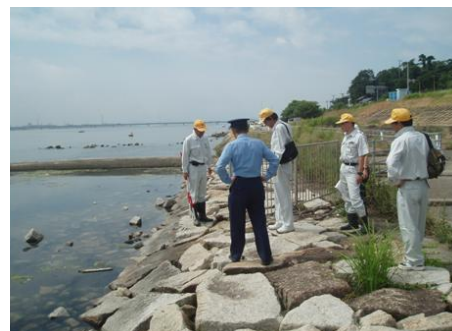
共同安全利用点検の状況（高梁川）
