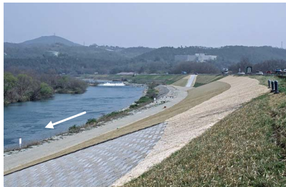
堤防補強の状況（高梁川酒津地区）
