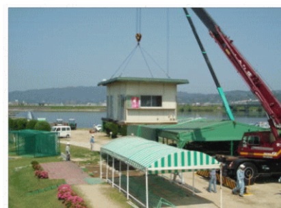
霞橋ゴルフ場上屋の撤去訓練
