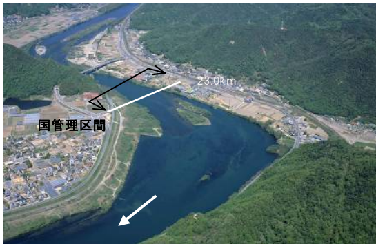
高梁川 国管理区間の上流端付近
