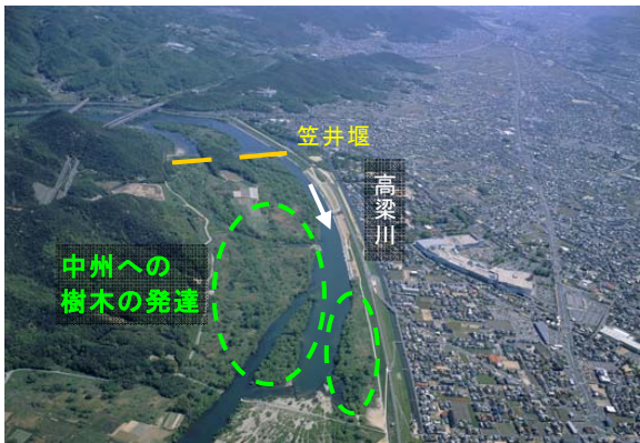
笠井堰付近の樹木の繁茂
