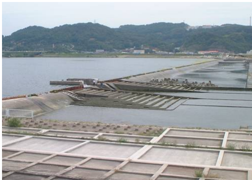
魚道現況(潮止堰)
