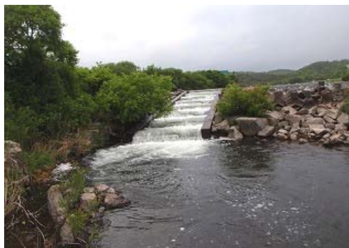
魚道現況(笠井堰)
