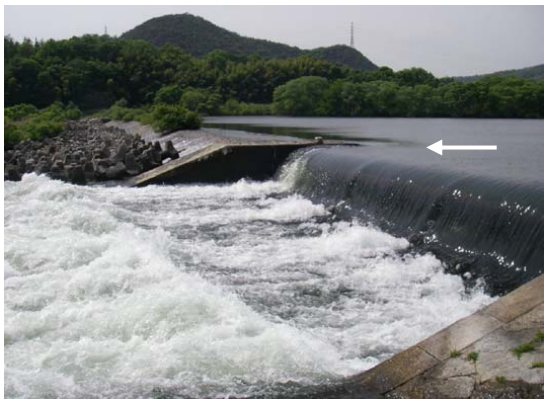
笠井堰(固定堰)
