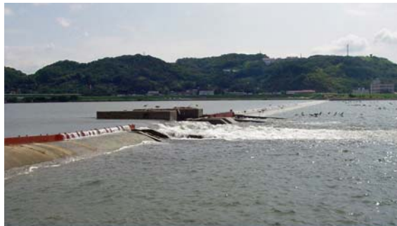
潮止堰の魚道の現状
