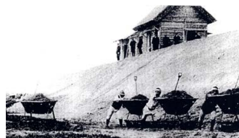
酒津付近の築堤工事(明治 44 年)
