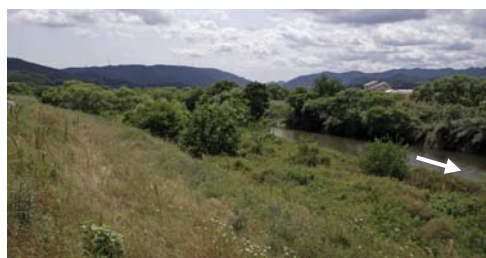
小田川 植生の繁茂状況
