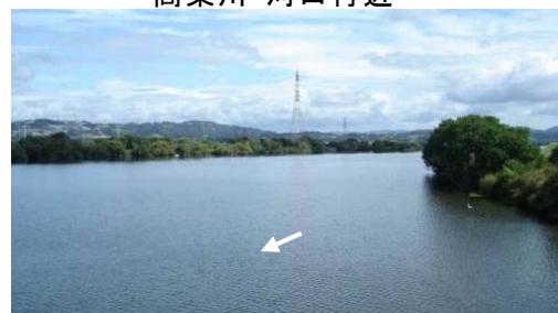
高梁川 潮止堰上流の湛水区間
