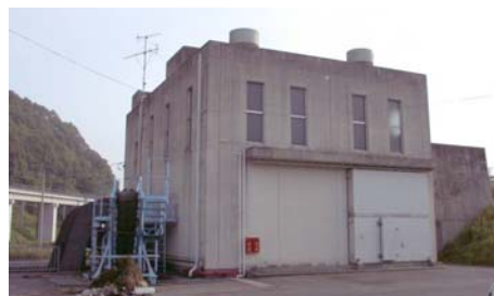
軽部排水機場(ポンプ場)
