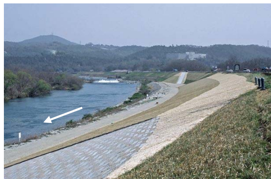
堤防補強の状況（高梁川酒津地区）
