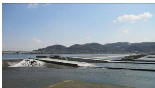
潮止堰の魚道の現状
