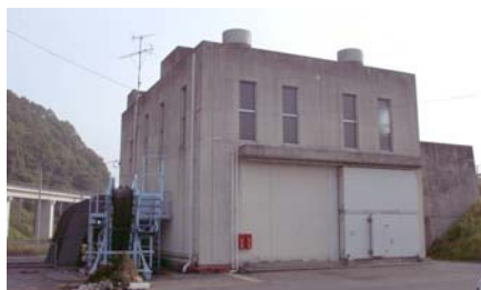
軽部排水機場(ポンプ場)
