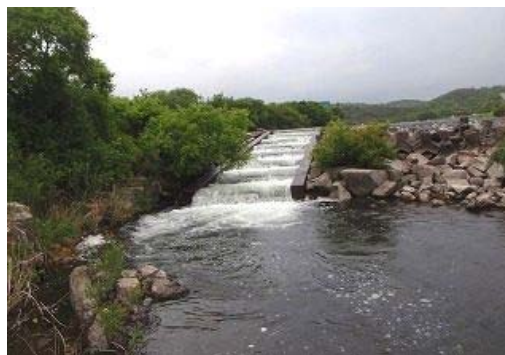
魚道現況（笠井堰）
