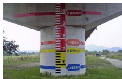
橋脚への量水標の設置状況 (高梁川)
