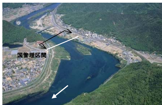
高梁川 国管理区間の上流端付近
