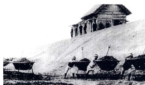
酒津付近の築堤工事(明治 44 年)
