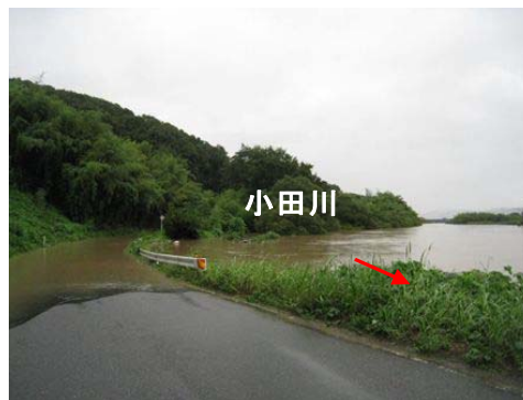
位置：倉敷市真備町川辺 小田川付近の状況（平成23年9月洪水）
