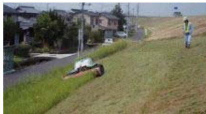
堤防の除草状況
