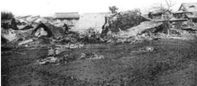
位置：倉敷市真備町川辺字辻尾 出典：岡山縣水害写真帖（明治26年） 高梁川の家屋被災状況（明治26年10月洪水）
