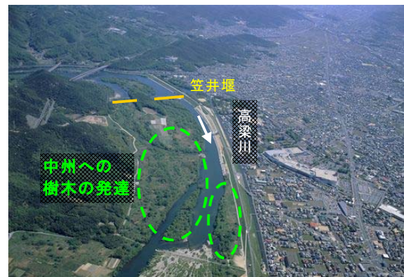
笠井堰付近の樹木の繁茂
