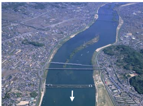
高梁川 潮止堰上流
