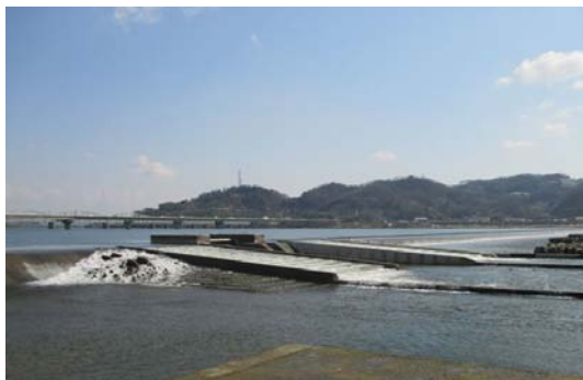
魚道現況（潮止堰：改良後）
