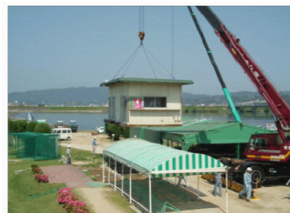
霞橋ゴルフ場上屋の撤去訓練
