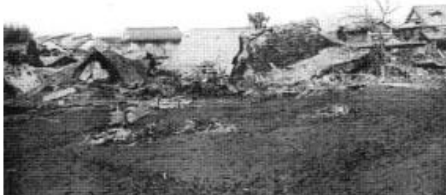
高梁川の家屋被災状況（明治26年10月洪水） 位置：倉敷市真備町川辺字辻尾 出典：岡山縣水害写真帖（明治26年）
