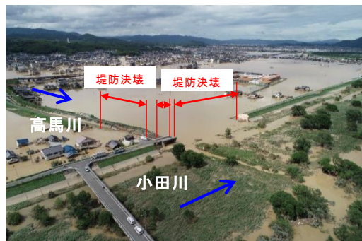
小田川の堤防決壊による浸水状況 （平成30年7月豪雨） 位置：倉敷市真備町
