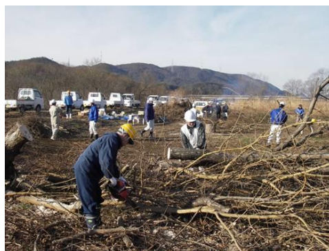
公募による樹木伐採状況
