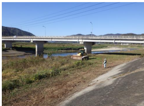
ブルドーザーによる草の踏み倒し
