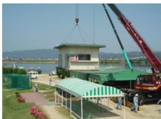
霞橋ゴルフ場上屋の撤去訓練
