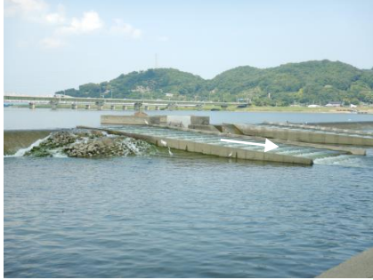
潮止堰の魚道の現状
