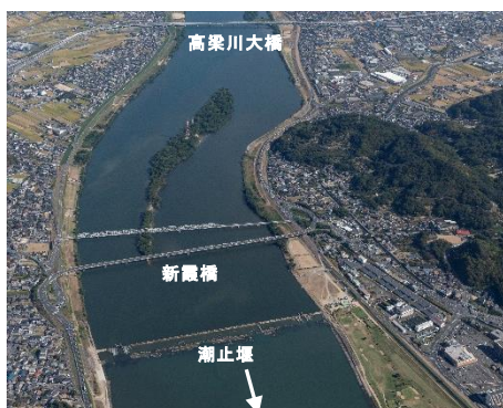
潮止堰上流の湛水区間
