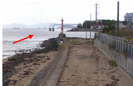
堤防の未整備区間の状況（高梁川河口付近）
