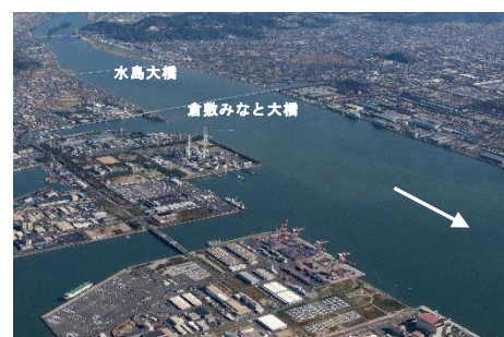
高梁川河口付近
