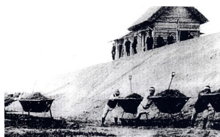
酒津付近の築堤工事（明治 44 年）
