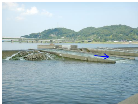
魚道現況（潮止堰：改良後）
