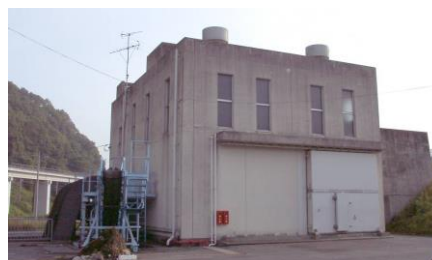
軽部排水機場（ポンプ場）
