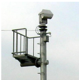
河川監視カメラ
