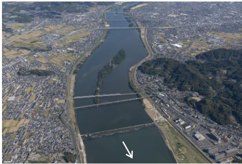
高梁川 潮止堰上流
