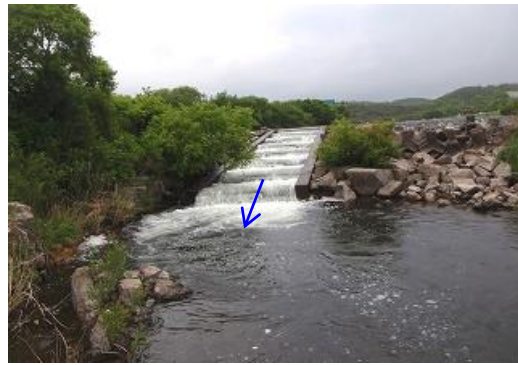
魚道現況（笠井堰）
