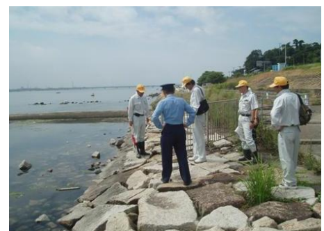
共同安全利用点検の状況（高梁川）
