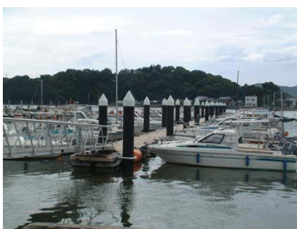
小型船舶係留施設（乙島西地区） （岡山県管理）
