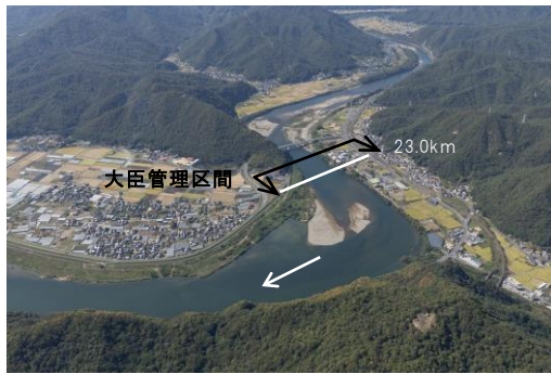
高梁川 大臣管理区間の上流端付近
