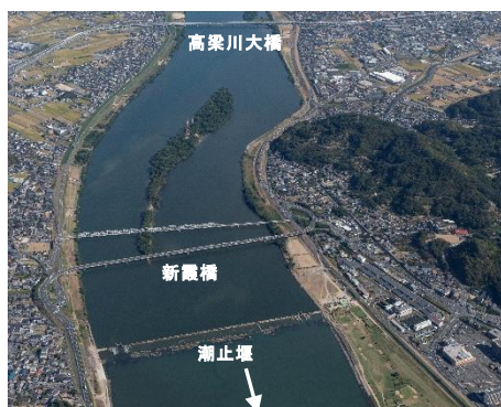
潮止堰上流の湛水区間
