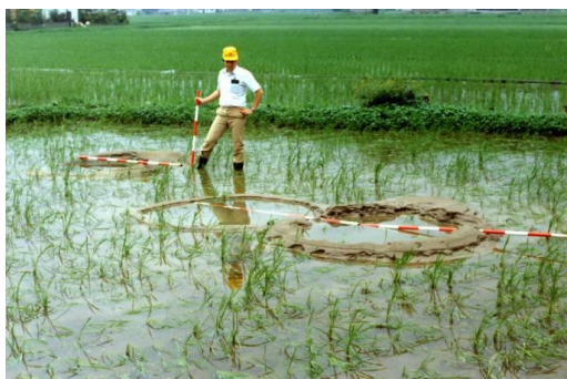
砂の噴出に伴う陥没の発生状況（昭和60年6月洪水） 位置：倉敷市真備町
