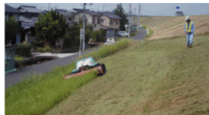
堤防の除草状況
