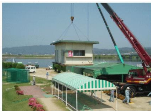
霞橋ゴルフ場上屋の撤去訓練
