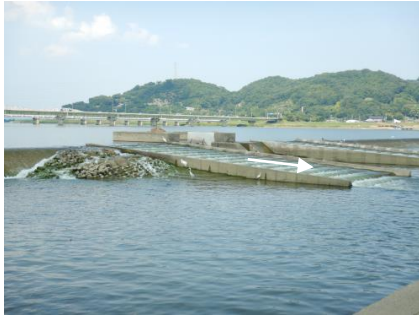
潮止堰の魚道の現状
