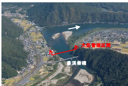
高梁川 大臣管理区間の上流端付近
