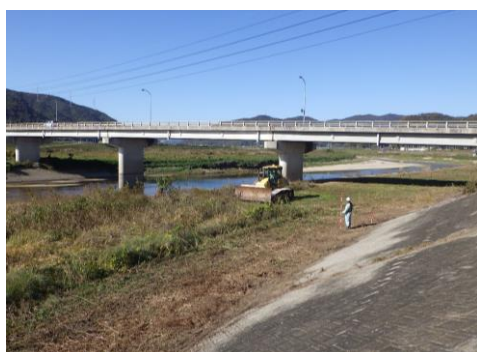
ブルドーザーによる草の踏み倒し
