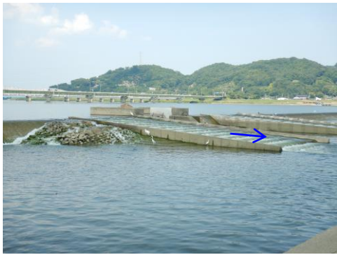
魚道現況（潮止堰：改良後）
