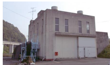
軽部排水機場（ポンプ場）
