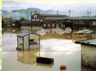
和気町金剛橋右岸の浸水状況
