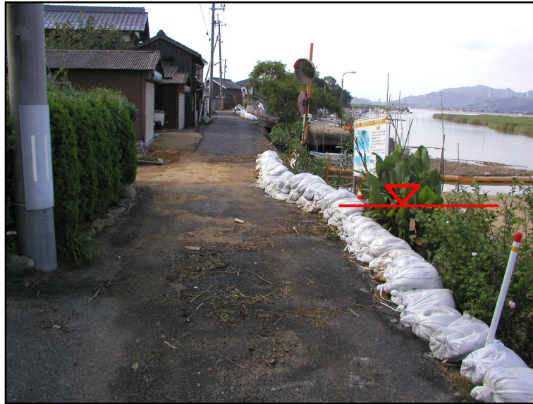
平成16年8月台風16号高潮災害(岡山市乙子地区)
