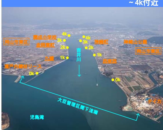
吉井川0k (大臣管理区間下流端河口部) ~ 4k付近
