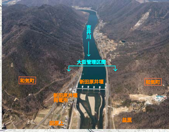
⑦ 大臣管理区間上流端 付近(新田原井堰)
