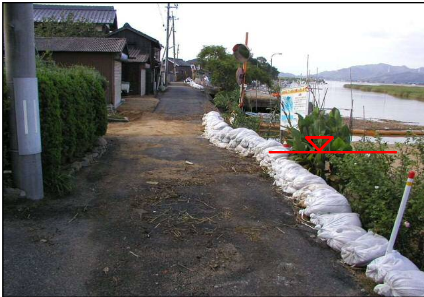
平成16年8月台風16号高潮災害(岡山市乙子地区)
