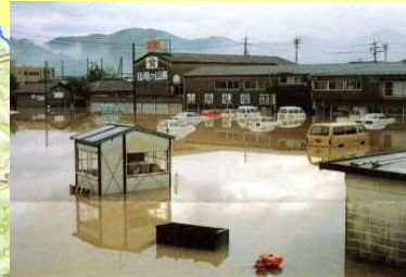
和気町金剛橋右岸の浸水状況
