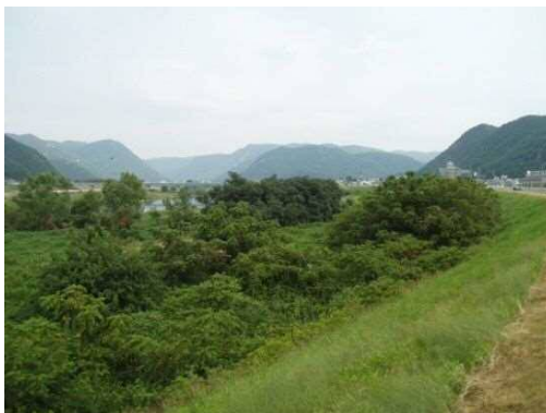
河道内の樹林化
