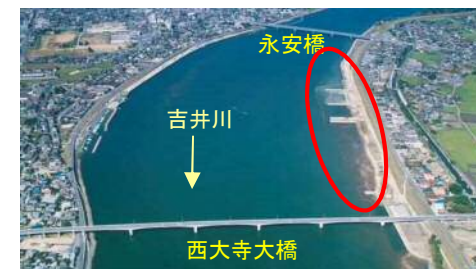
新地箇所の水制工
