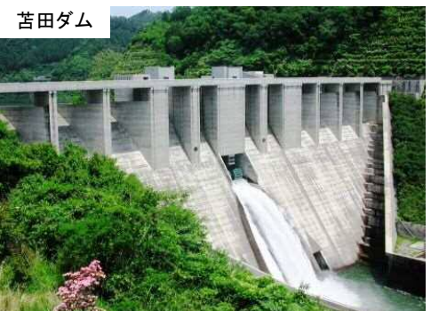
苫田ダム 目的: 洪水調節、上水、工水、かんがい、発電、流水の正常な機能の維持 堤高: 74m 総貯水容量: 84,100千m³ 利水容量: 28,100千m³ 完成年: 平成17年 管理者: 国土交通省
