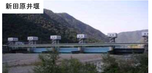
新田原井堰 目的: 利水(農業用水) 利水容量: 2,000千m³
