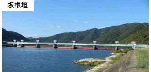
坂根堰 目的: 治水、利水(上工水、維持流量) 利水容量: 1,600千m³
