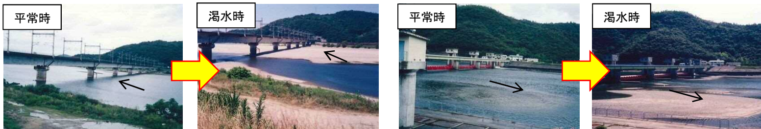
吉井川16k付近(JR山陽新幹線吉井川橋梁)
