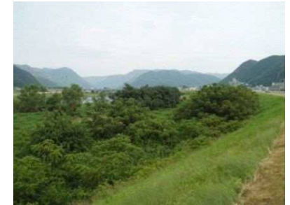
河道内の樹林化
