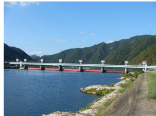
坂根堰 (S55.4完成 国土交通省管理)
