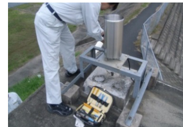
水文観測施設点検
