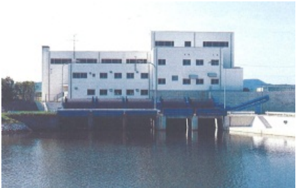
写真2.1.3干田川排水機場 (昭和56年完成、平成6年増設)
