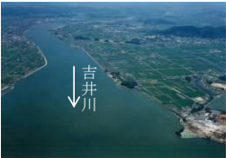
写真2.3.1 吉井川河口付近
