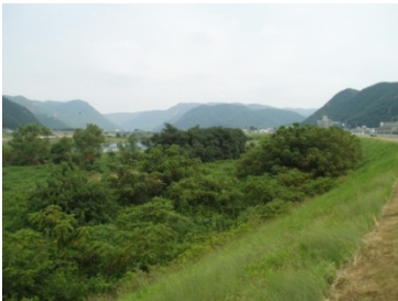
写真2.4.1 河道内の樹林化
