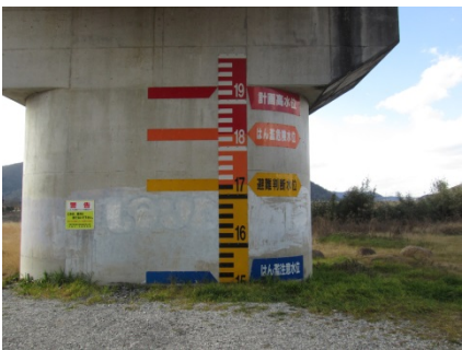
写真5.2.2 水位表示の設置状況
