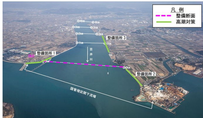
写真5.1.1 吉井川 0.0k付近
