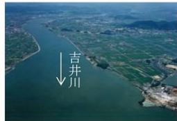
写真 2.3.1 吉井川河口付近
