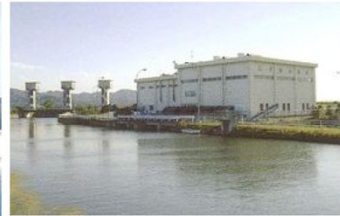
写真 2.1.4 乙子排水機場 (昭和54年完成、平成6年増設)
