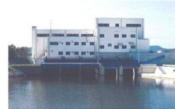
写真 2.1.3 千田川排水機場 (昭和56年完成、平成6年増設)
