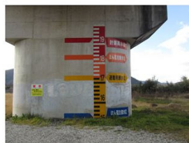
写真 5.2.2 水位表示の設置状況
