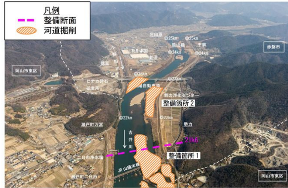
写真5.1.4 吉井川 21.6k付近
