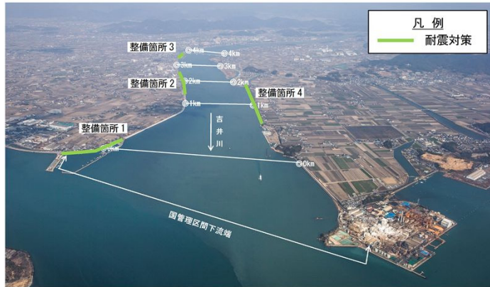
写真5.1.2 耐震対策区間
