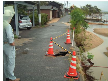
写真 2.1.2 高潮被害状況 (平成16年8月:西幸西地先)
