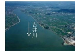
写真 2.3.1 吉井川河口付近
