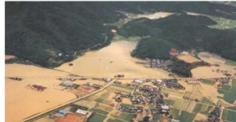
写真 1.2.4 平成29年9月(台風19号)洪水の状況 (瀬戸内市(旧長船町))
