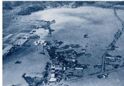
写真 1.2.3 昭和51年9月(台風17号)洪水の状況 (瀬戸内市(旧長船町))
