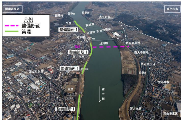
写真5.1.3 吉井川 6.6k付近
