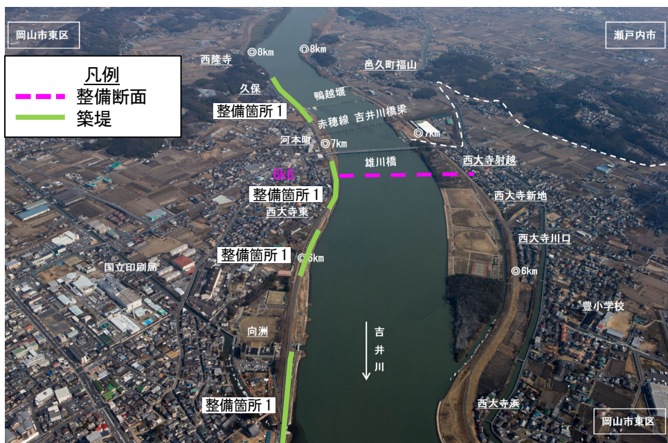
写真5.1.3 吉井川 6.6k付近
