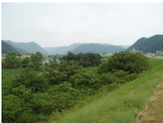
写真 2.1.1 河道内の樹林化状況
