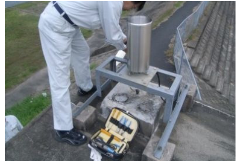
写真 5.2.1 水文観測施設点検状況
