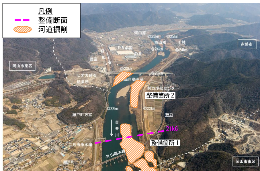
18 写真5.1.4 吉井川 21.6k付近
