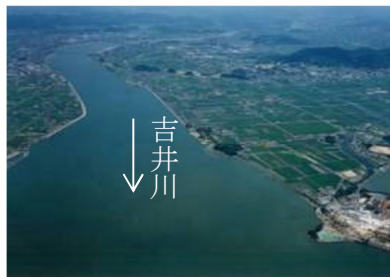
写真 2.3.1 吉井川河口付近
