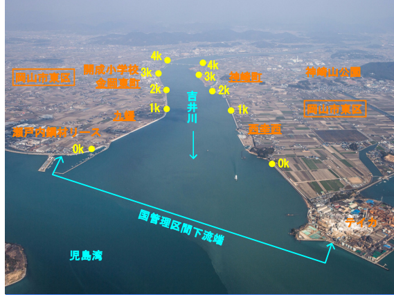
① 吉井川0k(国管理区間下流端河口部)~4k付近
