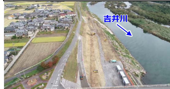
河川改修前（熊山地先、撮影日：令和3年10月）
