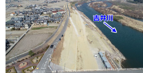
河川改修後（熊山地先、撮影日：令和4年3月）
