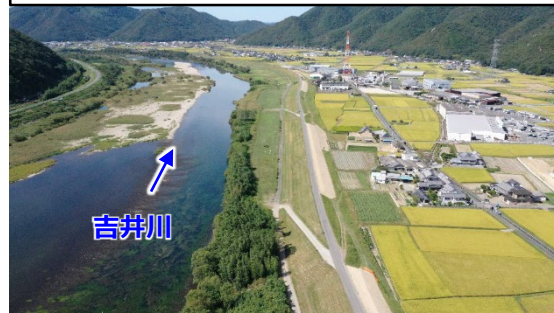
河川改修前（田原地先、撮影日：令和2年9月）
