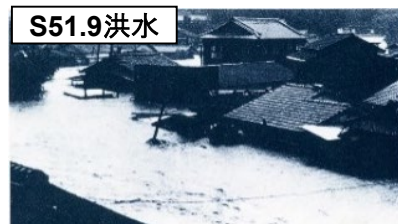
備前市の浸水状況
