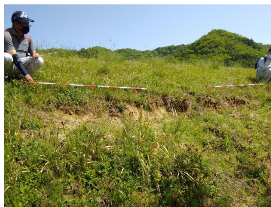
堤防点検の様子
