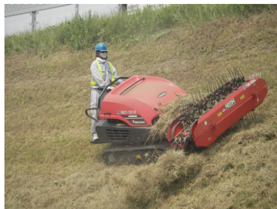
除草作業の状況
