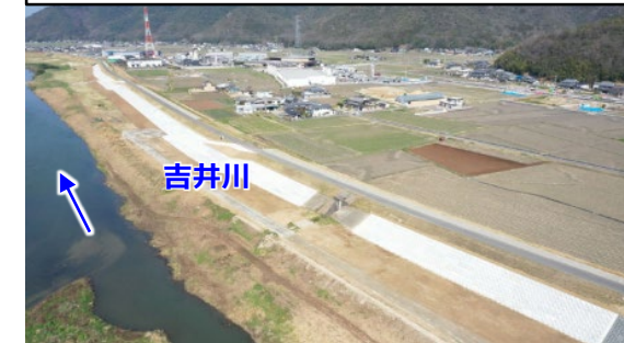
河川改修後（田原地先、撮影日：令和3年3月）
