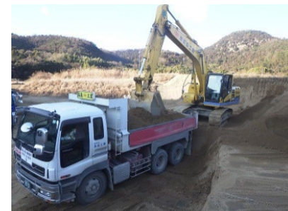
土砂採取 (仮置き場)
