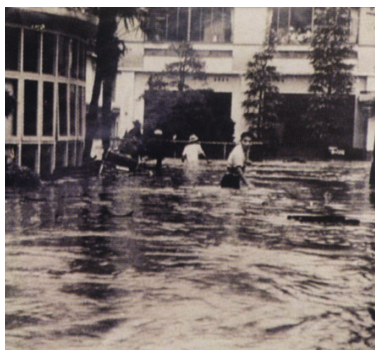
写真 1.2.1 昭和 38 年 7 月（梅雨前線）洪水の状況 （美作市（旧美作町））
