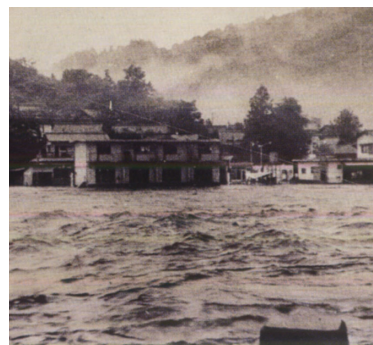
写真 1.2.2 昭和 47 年 7 月（梅雨前線）洪水の状況 （美咲町（旧柵原町））
