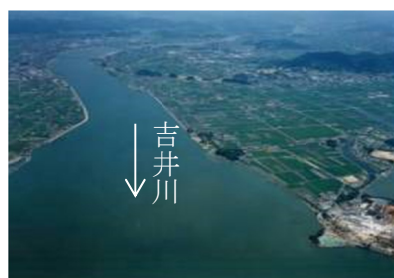
写真 2.3.1 吉井川河口付近
