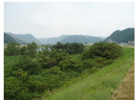
写真2.4.1 河道内の樹林化
