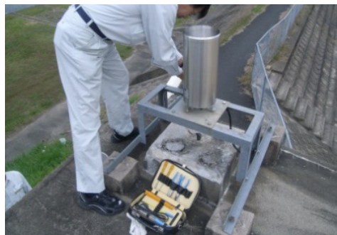
写真 5.2.1 水文観測施設点検状況
