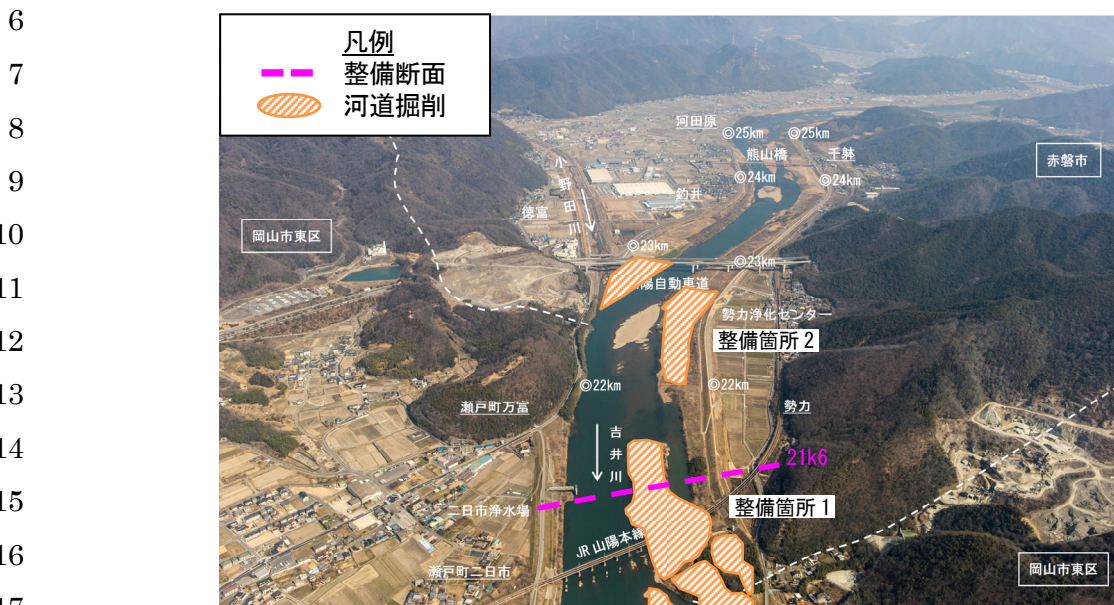
18 写真5.1.4 吉井川 21.6k付近
