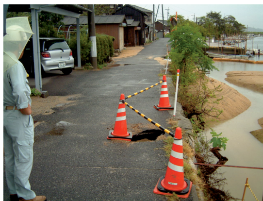
写真 2.1.2 高潮被害状況 (平成16年8月：西幸西地先)
