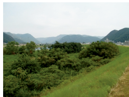
写真2.4.1 河道内の樹林化
