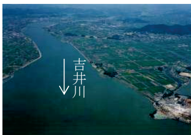
写真 2.3.1 吉井川河口付近
