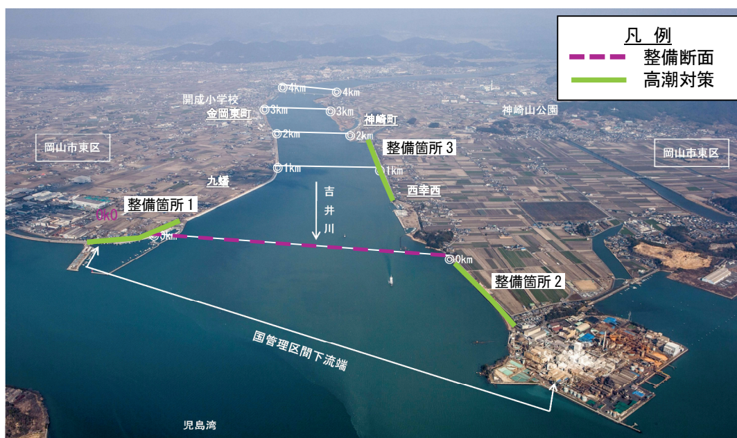
写真5.1.1 吉井川 0.0k付近
