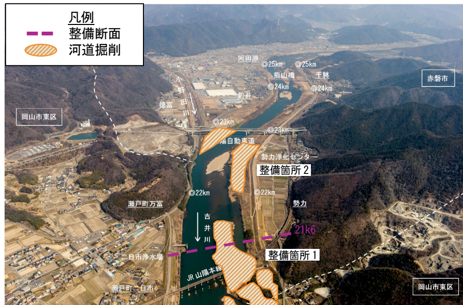
写真5.1.4 吉井川 21.6k付近
