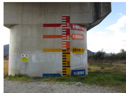
写真 5.2.2 水位表示の設置状況
