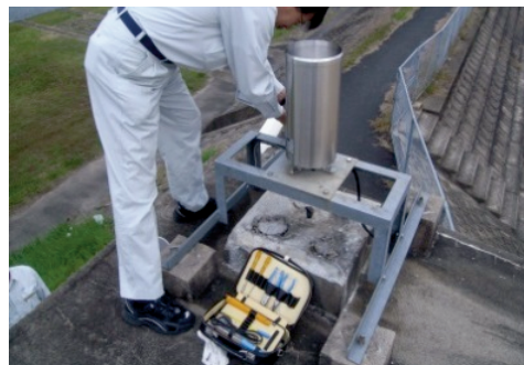
写真 5.2.1 水文観測施設点検状況
