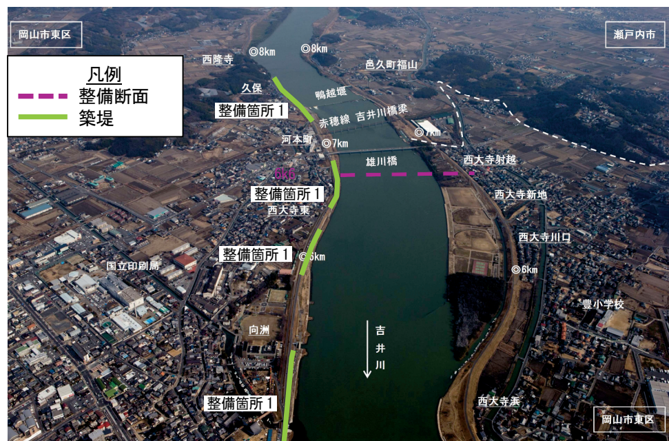
写真5.1.3 吉井川 6.6k付近
