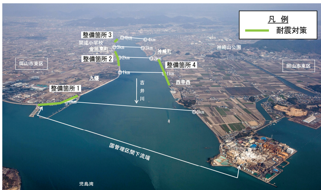
写真5.1.2 耐震対策区間
