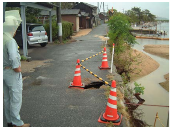
写真 2.1.2 高潮被害状況 (平成16年8月：西幸西地先)
