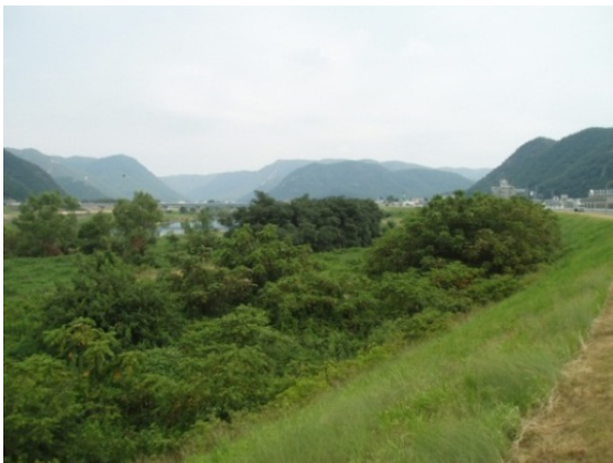
写真 2.1.1 河道内の樹林化状況
