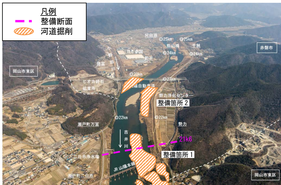
18 写真5.1.4 吉井川 21.6k付近
