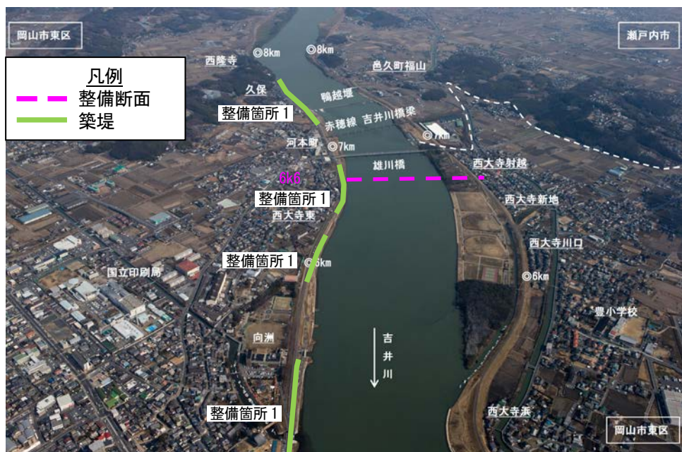
25 写真5.1.3 吉井川 6.6k付近
