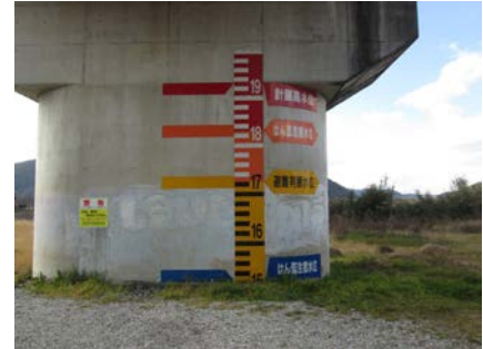
写真 5.2.2 水位表示の設置状況
