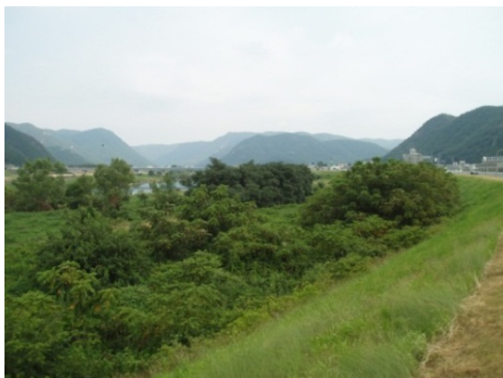
写真 2.1.1 河道内の樹林化状況
