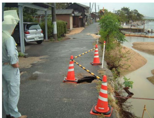
写真 2.1.2 高潮被害状況 (平成16年8月：西幸西地先)
