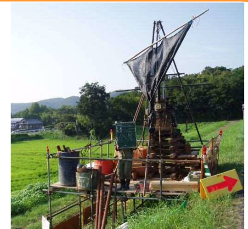
ボーリング調査の状況
