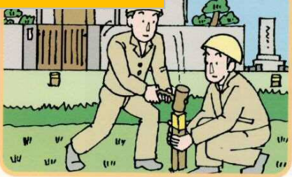
用地幅杭の設置
