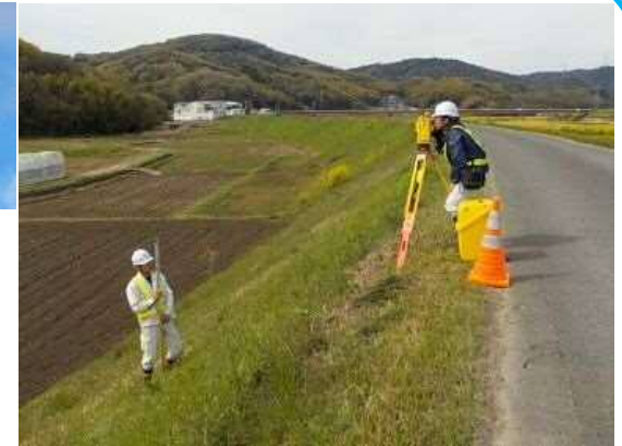
測量作業の状況
