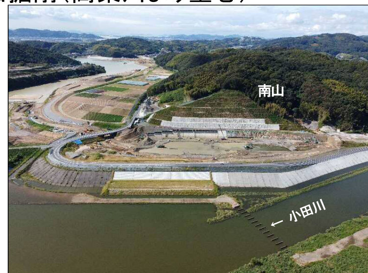
②南山掘削(高梁川より望む)
