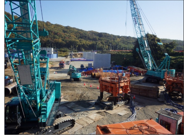
現地作業状況
