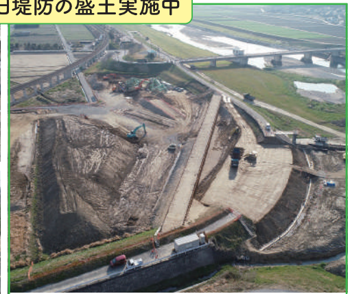
工事進捗状況 (平成31年2月末現在)
