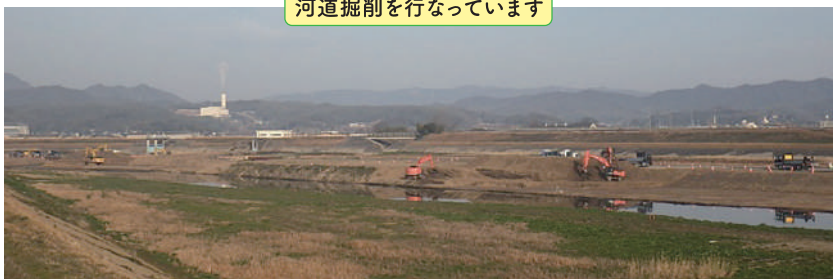
河道掘削を行なっています
