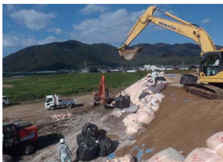
大型土のう撤去状況
