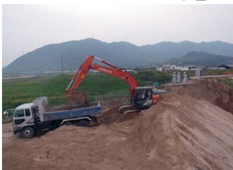
荒締切堤撤去状況
