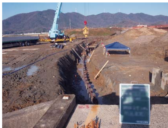
破堤箇所復旧作業（矢板打ち込み状況）
