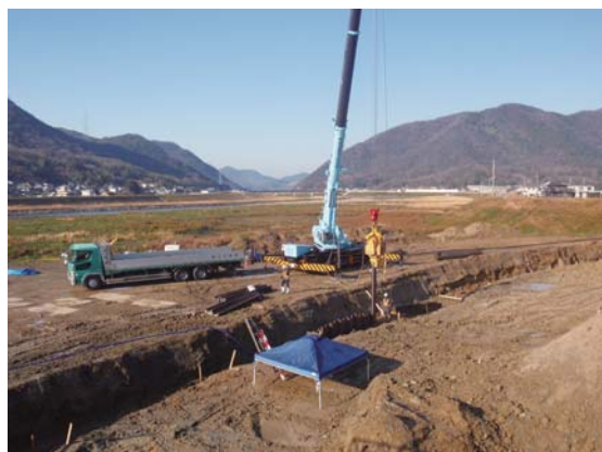
破堤箇所復旧作業（矢板打ち込み状況）
