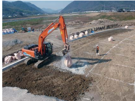
破堤箇所復旧作業（築堤盛土施工状況）
