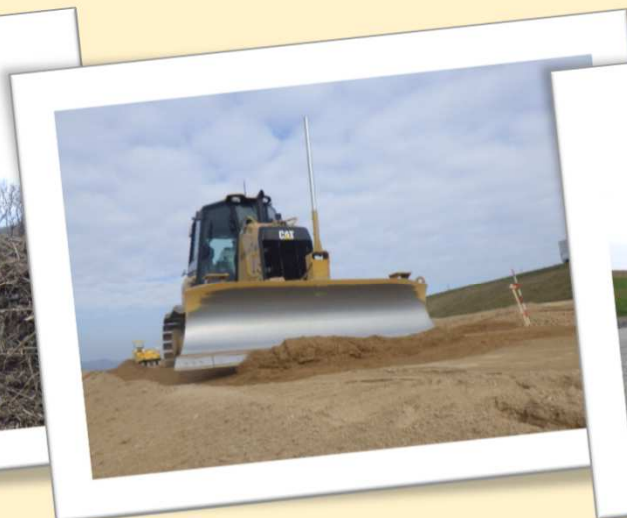
仮設盛土を行い
