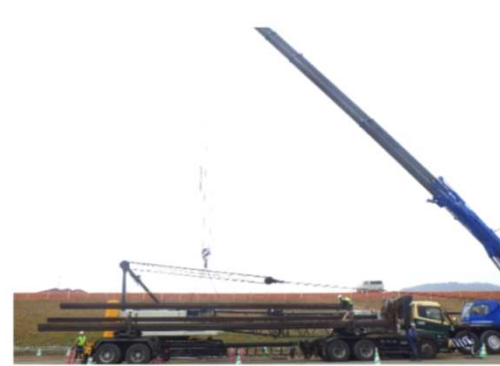
製作された鋼矢板が搬入され
