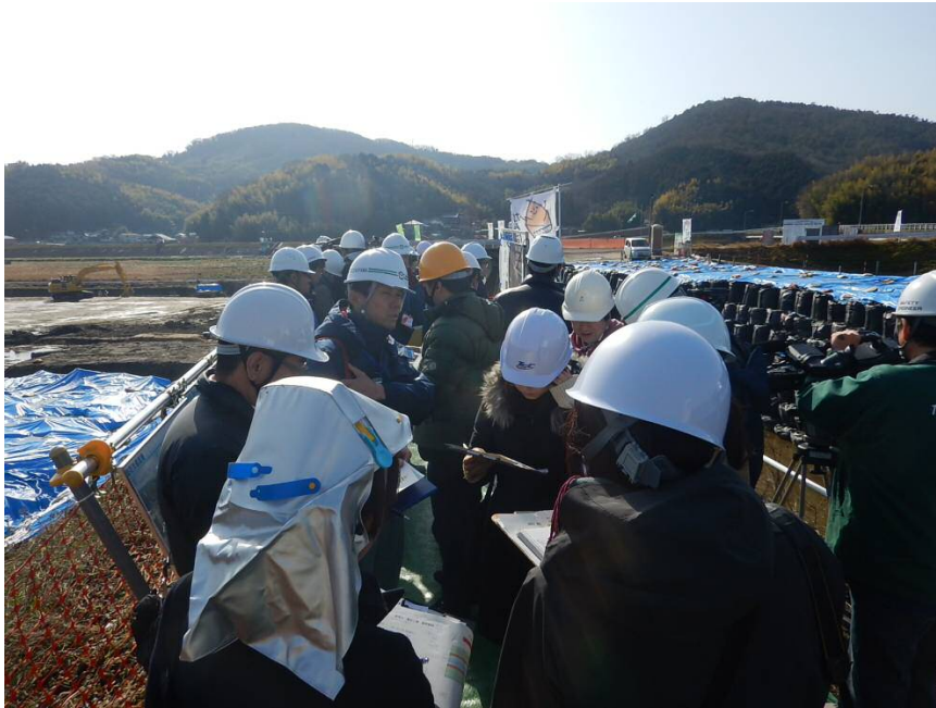
災害復旧工事説明（小田川左岸3K400地点）
