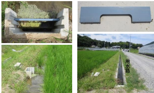
堰板等設置風景
