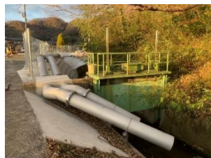
伊賀寺排水ポンプ場
