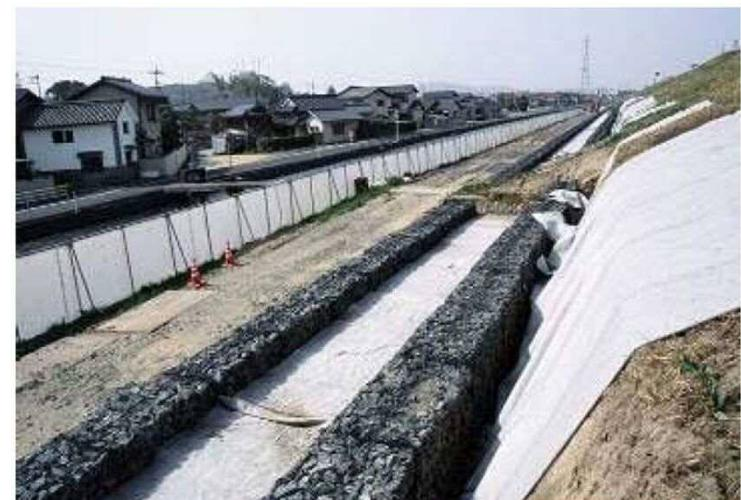
堤防補強におけるドレーン部の施工状況
